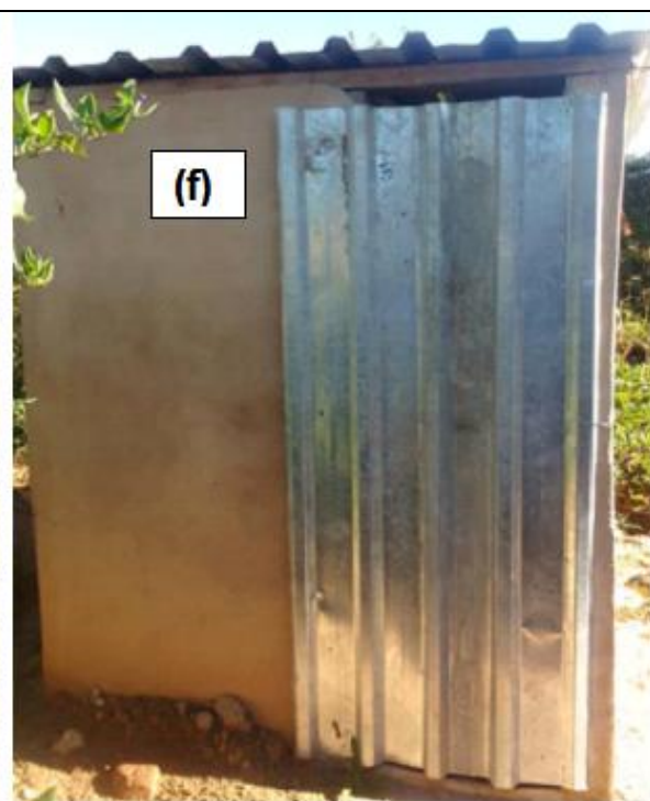
Incomplete BVIP Latrine (Ward 10)
