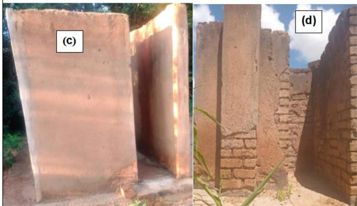
Incomplete BVIP latrine (Ward 1)
