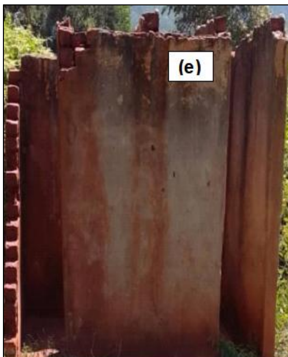
Incomplete BVIP latrine (Ward 6)
